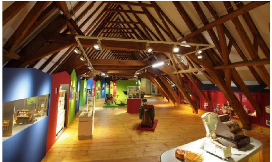
**Bild 4** In Baudenkmalen findet man häufig Holzböden und einen Holzdachstuhl wie hier im Schloss Moers. Quelle: Fogtec
